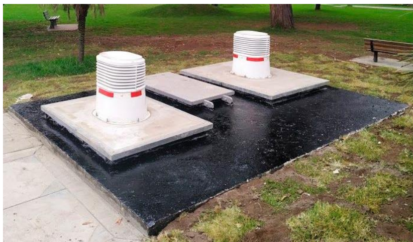
Ilustración 5 Tapa viciada en concreto
